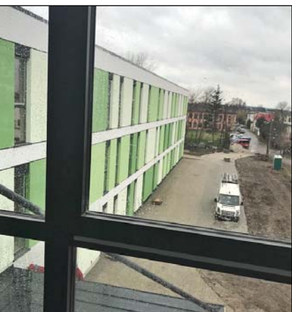
Widok z nad wejścia głównego.
