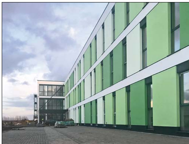
Nowo powstający budynek OREW.
