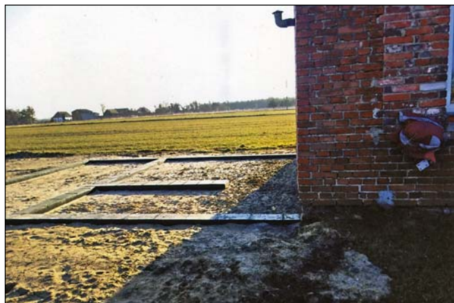
Fundamenty przy domu.
