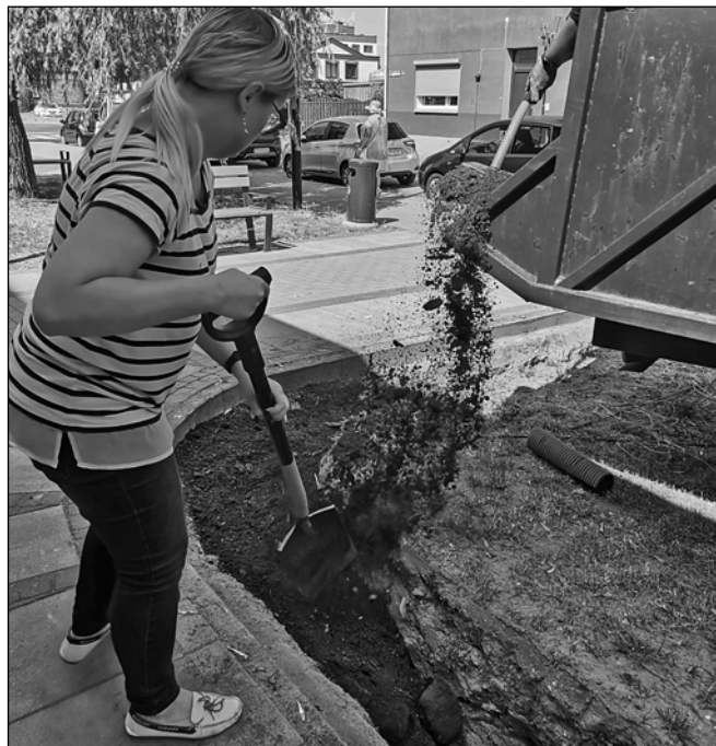
Wykonywanie prac ziemnych.
